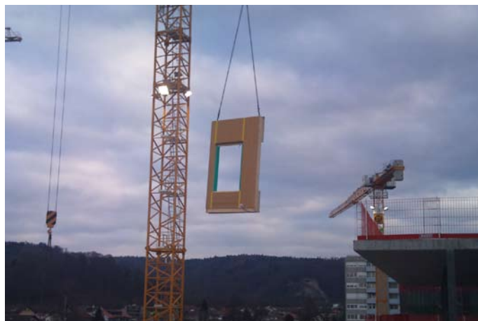
Element-Montage auf der Baustelle
