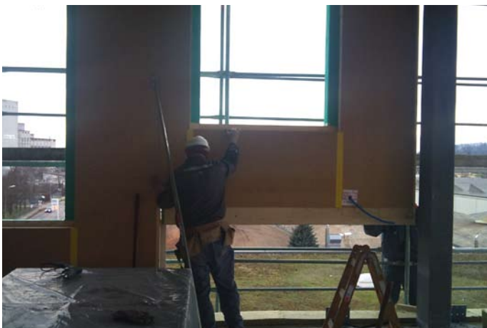
Massgenaue Elemente werden zusammengefügt.
