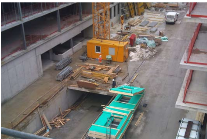
Anlieferung der Elemente
