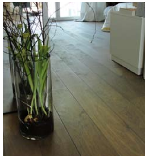
Die Durchgänge wurden nahtlos verlegt.
